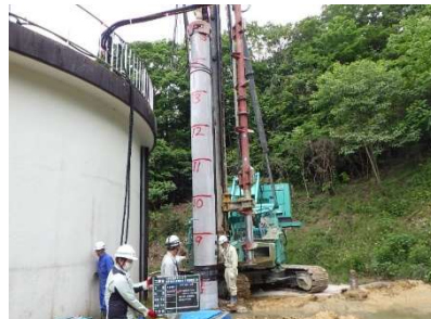
青野木配水所における耐震化工事
