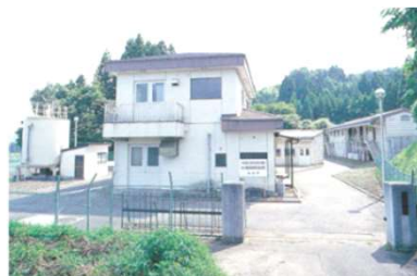
熊ヶ根浄水場
