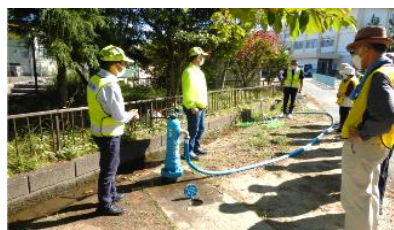
地域における災害時給水栓の開設訓練
