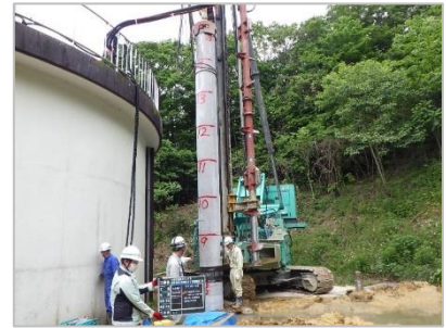
青野木配水所における耐震化工事
