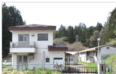
熊ヶ根浄水場
