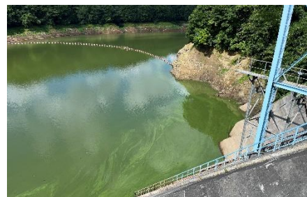
浄水処理に影響を与える水中生物（アオコ）が発生した七北田ダムの様子
