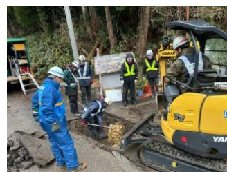
宮城県管工業協同組合と連携した復旧作業
