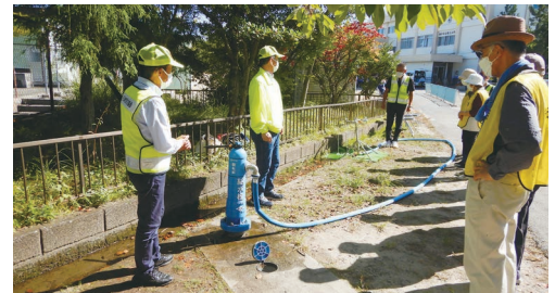
地域における災害時給水栓の開設訓練
