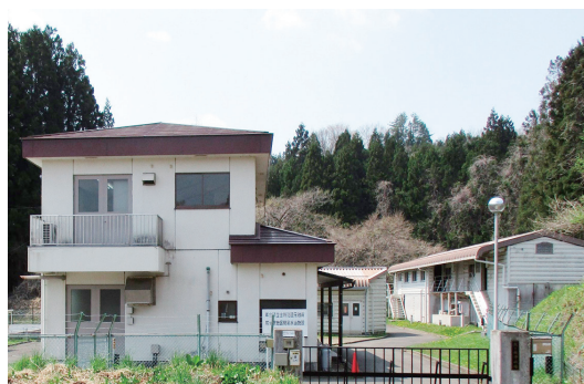
熊ヶ根浄水場
