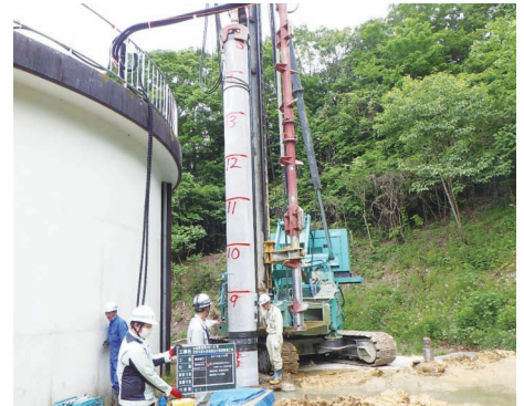
青野木配水所における耐震化工事
