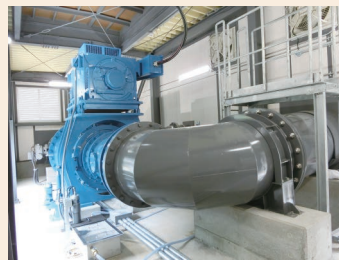
上追沢沈砂池の小水力発電 ※3 設備
