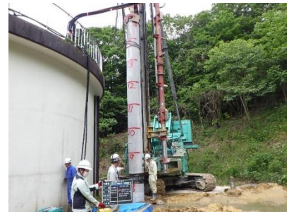
青野木配水所における耐震化工事
