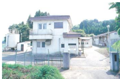
熊ヶ根浄水場
