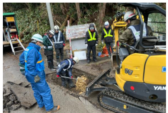
民間事業者と連携した復旧作業（令和6年能登半島地震）
